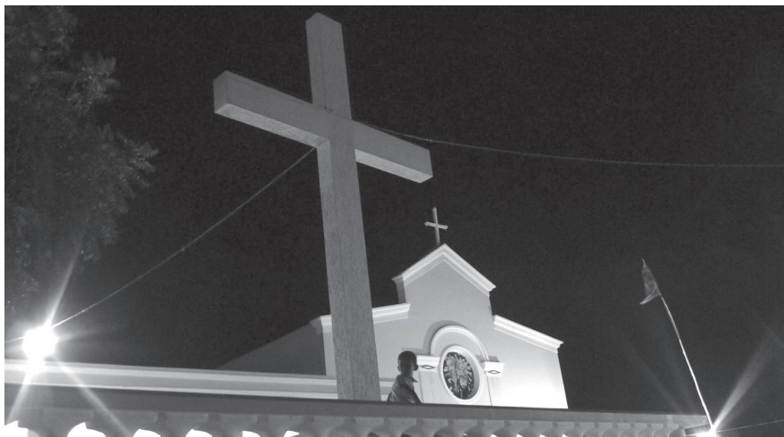
Mosteiro - distrito de Sussuanha.
